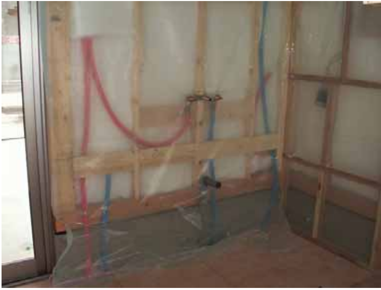
取り付け前の配管状況。
