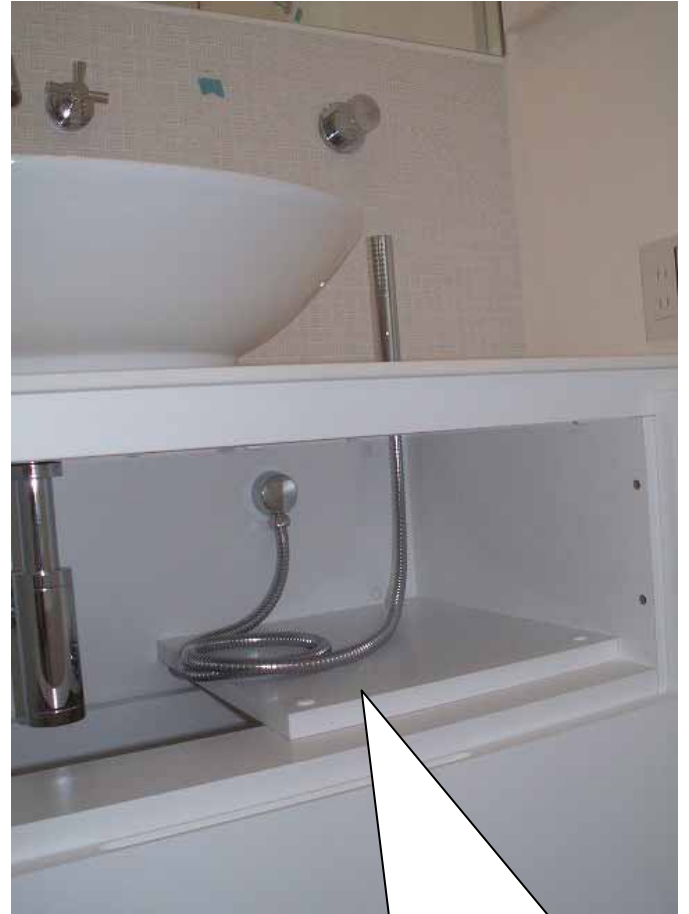
シャワーホースの受け板 受け板はホースの状況見てからの取り付けです。
