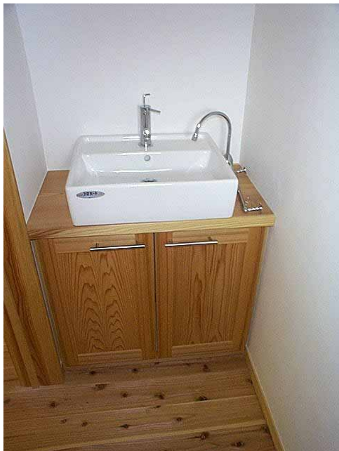
天板：杉通し板 前板：杉無垢板 ボウル：INAX GL-553
