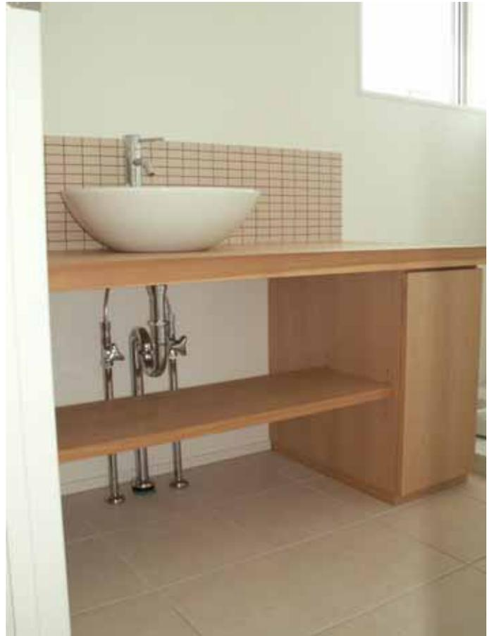
タモ柎目突板が落ち着いた雰囲気を出しています。また、床配管は十分にスペースを取り、きれいに収まっています。
