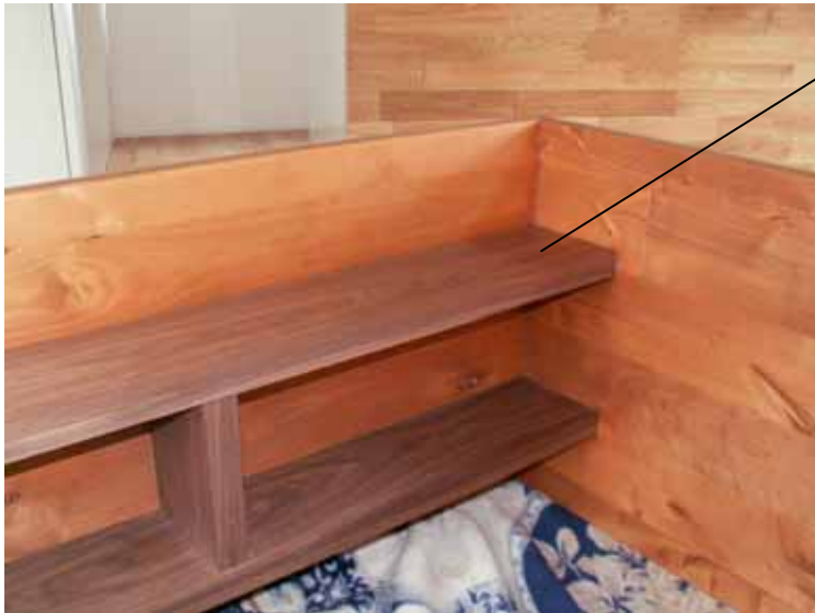
木口床板 2 枚合わせ目にウォールナット角材の埋め込み処理。
