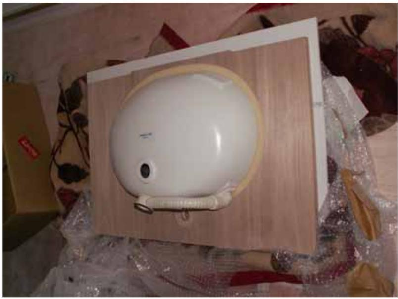
人大ボウルは天板人大とシーム材で固定しますが、さらに強度を得るためにポリウレタンをボウル周囲 15mm溝幅に流し込んで固定いたします。
