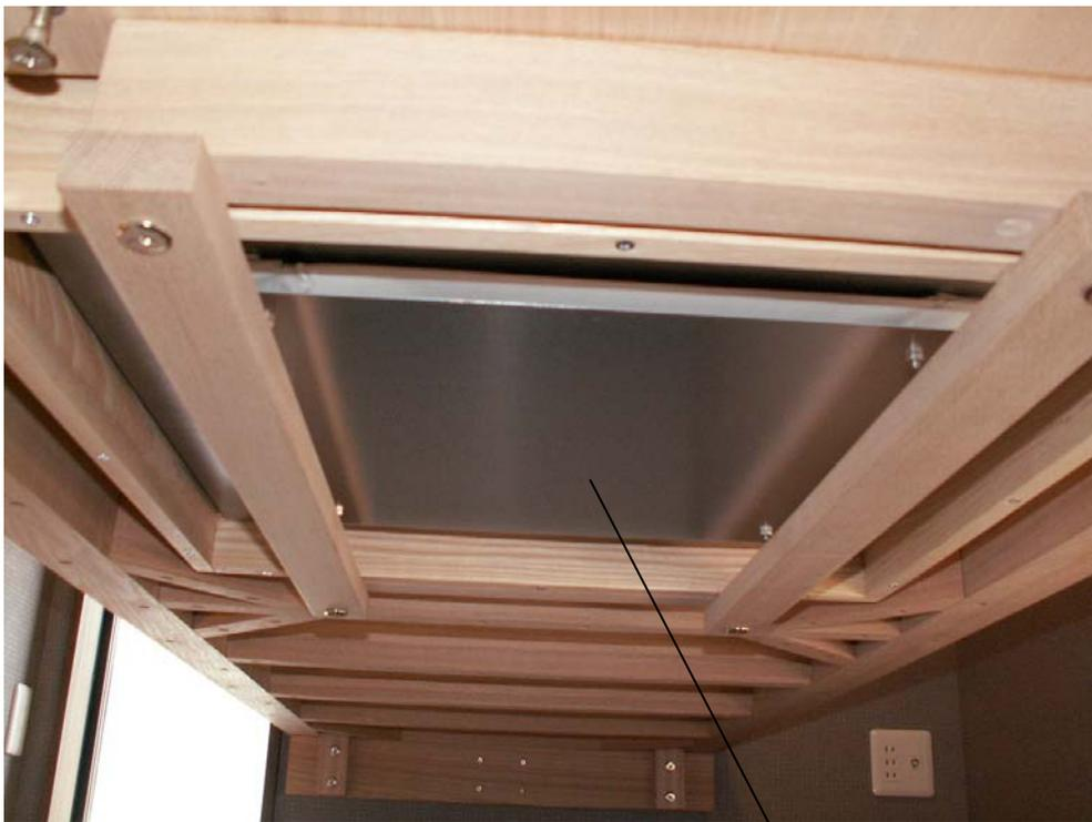
耐火レンガ下側に 2 枚のアルミ板が金属炉箱
