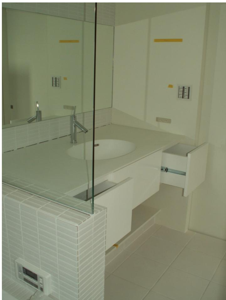
給湯操作盤の板厚を考慮して引出前板を割り付けています。
