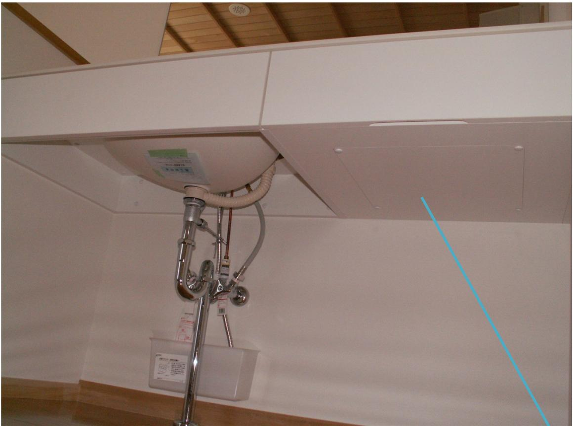
洗面ボックスはボウル部内部、引き出し部内部よりしっかりと固定しています。
