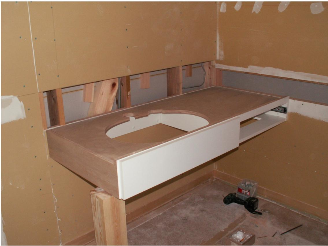
洗面ボックスを先に固定してから左側の仕切り壁を取り付けて左右、背面を固定します。
