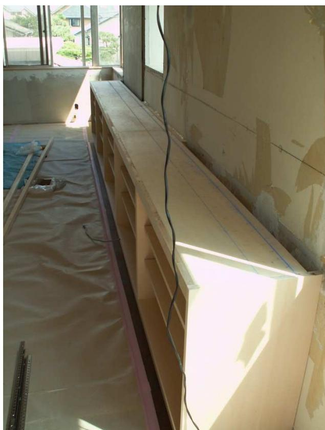
まず、箱自体がまっすぐであるかどうか確認し、長尺であるだけに多少のズレは補正して青い基準線を設定し、そこから 100mm ピッチでの壁までの距離を測定し、測定値より 2mm 短く各点を図面化しました。
