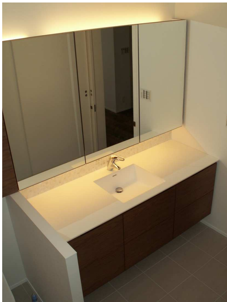
三面鏡収納部の上下の間接照明状況。
