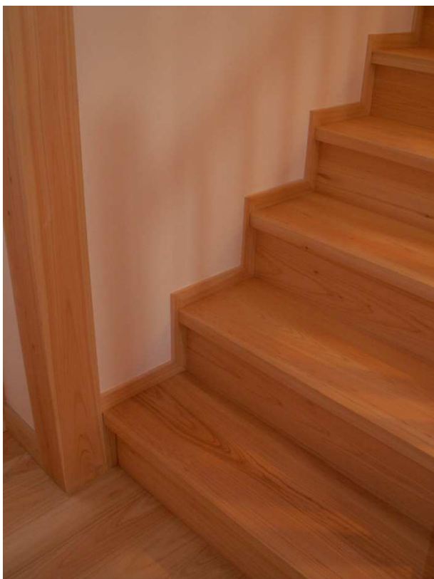
段板の壁側は回り巾木にて固定します。
