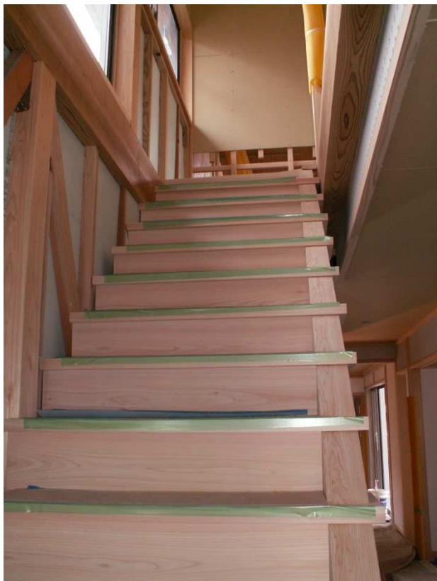
段板、蹴込板の取付け完了状況です。
