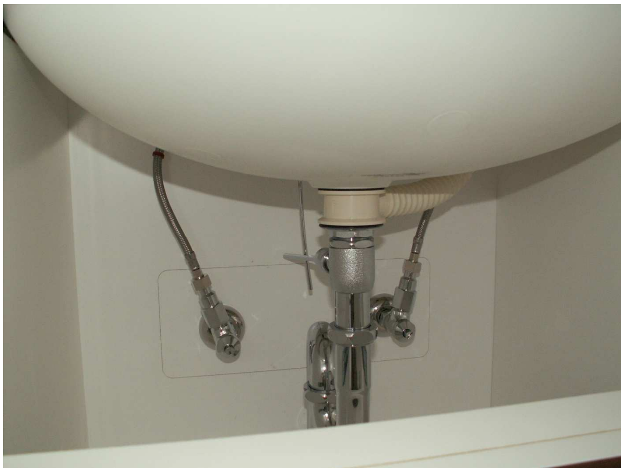
排水 S トラップと給水、給湯配管状況です。
