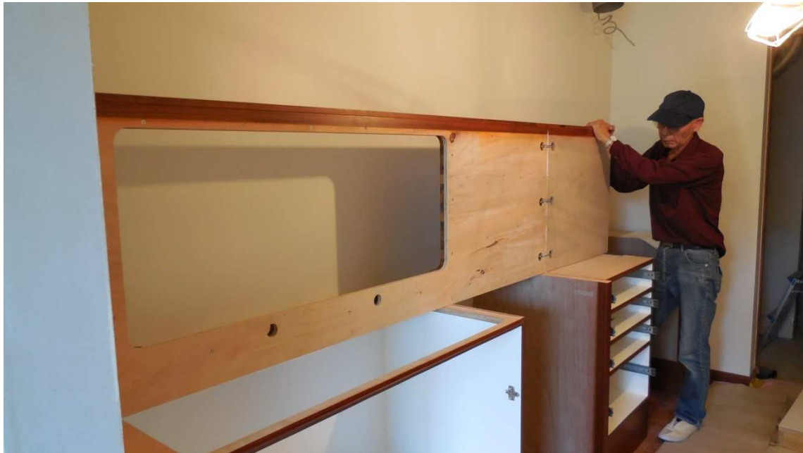
現場組立。 天板ジョイント 状況。
