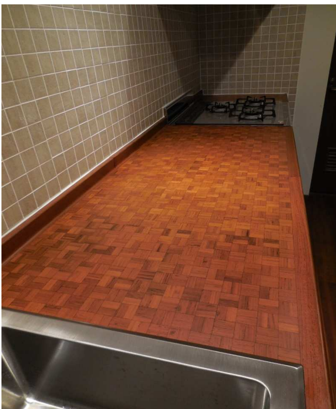
天板仕上がり状況。 塗装はウレタンクリアーです。 (普通のウレタン塗装より傷つきにくいものを使用。)
