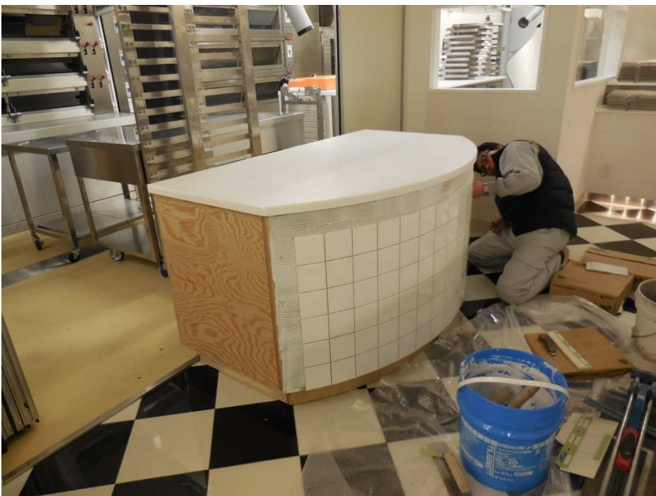
人大を載せてチリあわせ。 タイル貼り状況です。
