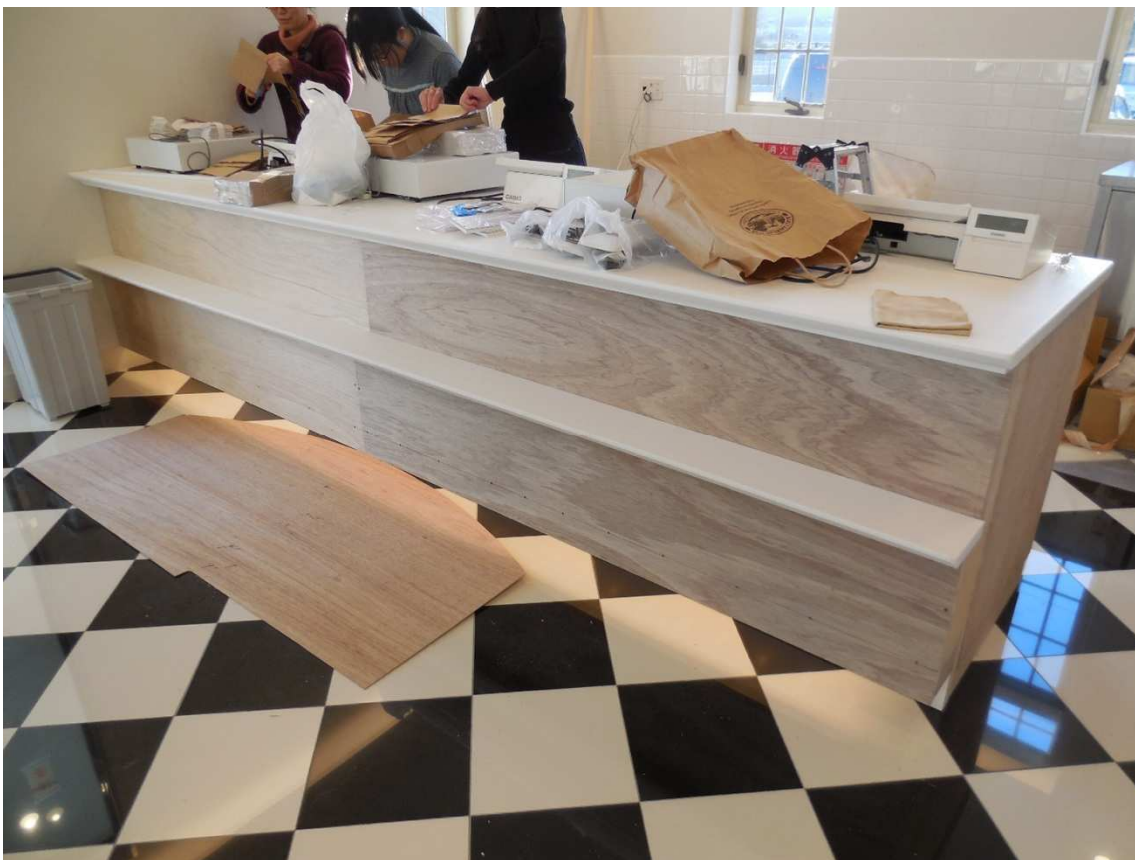
レジ台お客様側 人大バック置場取り付け、タイル下地合板取り付け。
