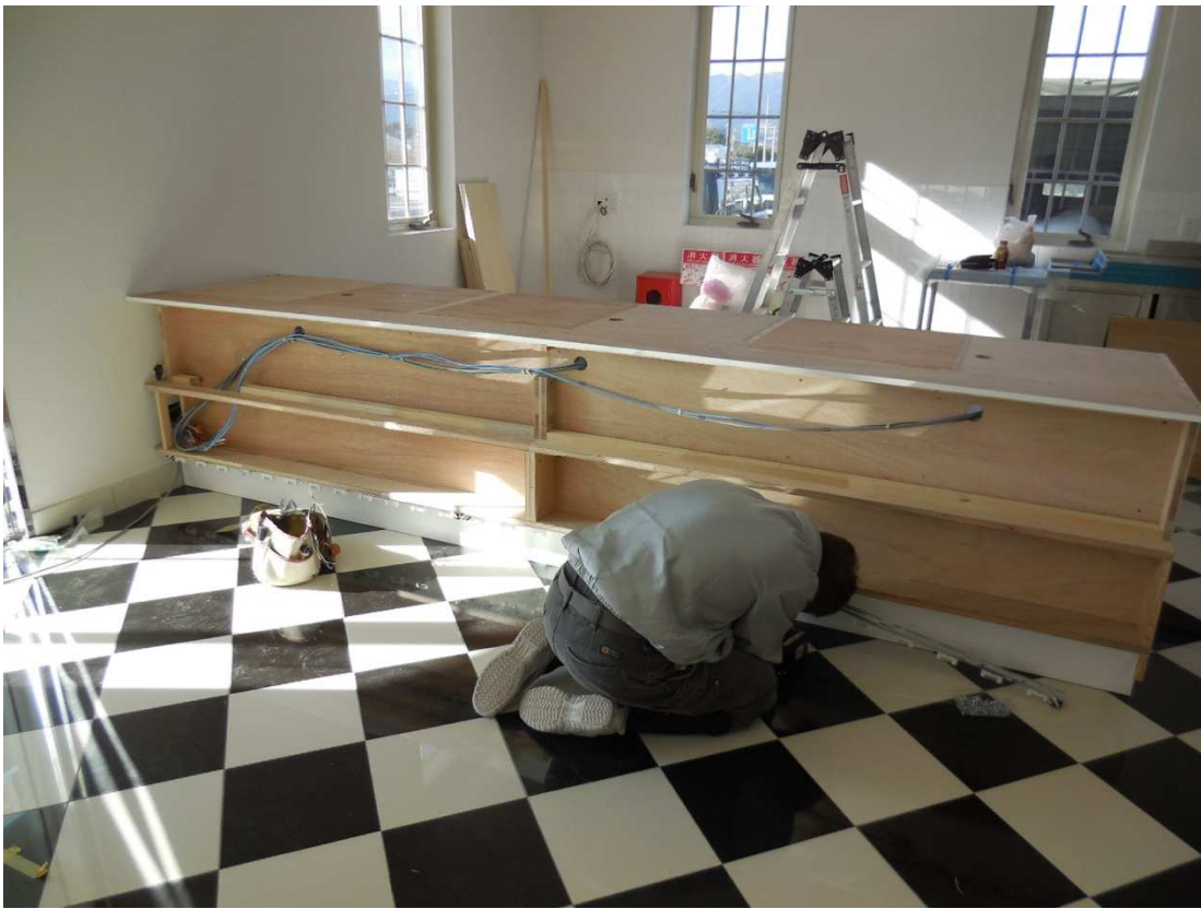
レジ台お客様側 レジスター配線 3 箇所、間接照明配線中。
