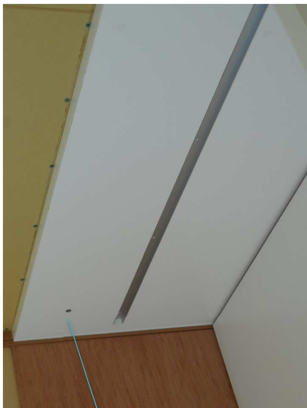
上レール取り付け状況。
