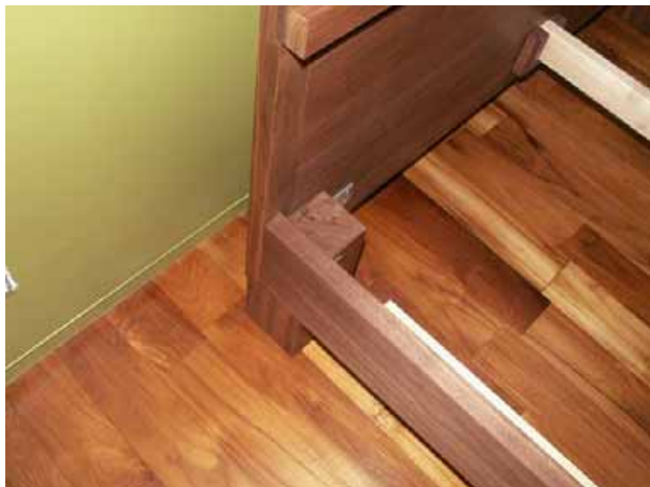
ヘッドボードとサイドレールの固定状況。 脚 100 角は 2 枚剥ぎ
