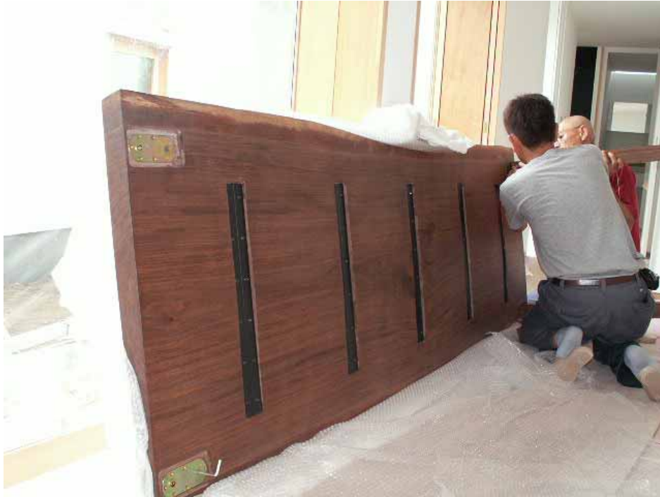
脚固定状況です。テーブルが重たく、起こし易い態勢で組み立てています。
