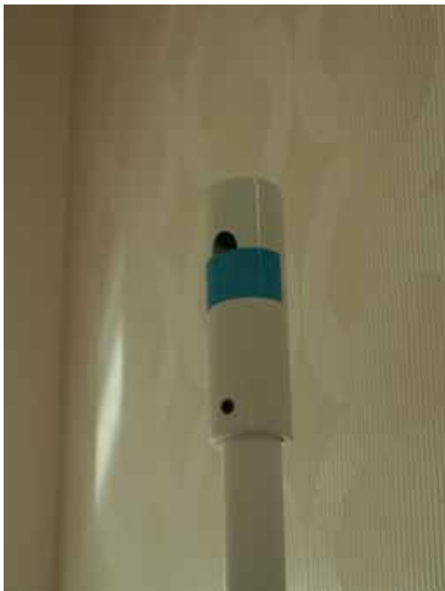
手摺支柱に手摺受けを差し込む。
