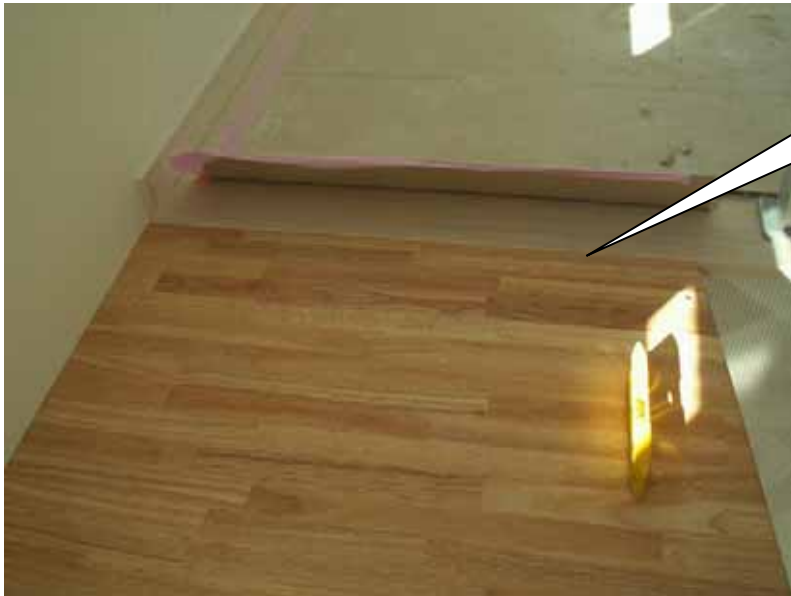
最上段の踊り場のセット状況。 壁の収まりも大体合っています。
