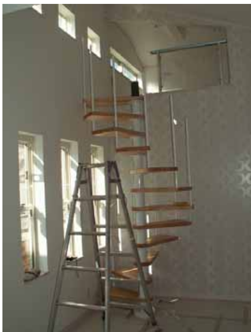
12段組み立て完了。
