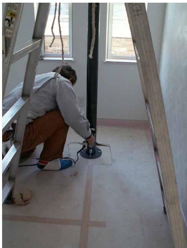
センターシャフト固定。
