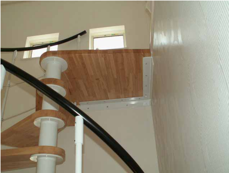
手摺取り付け完了。
