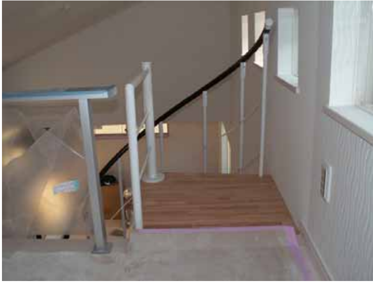
ロフト側からの取り合い状況。
