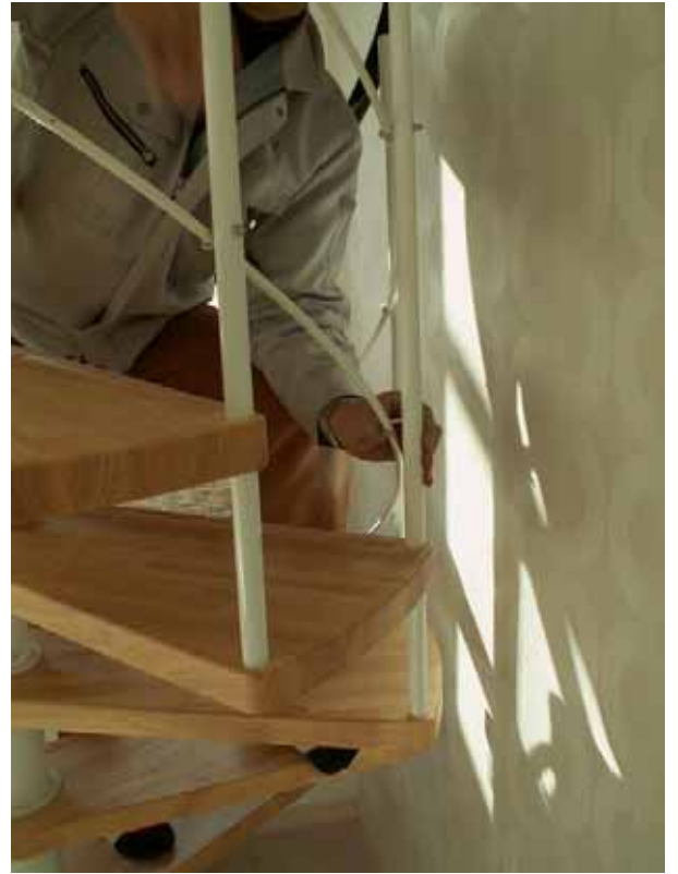
手摺下の鋼線の取り付け。
