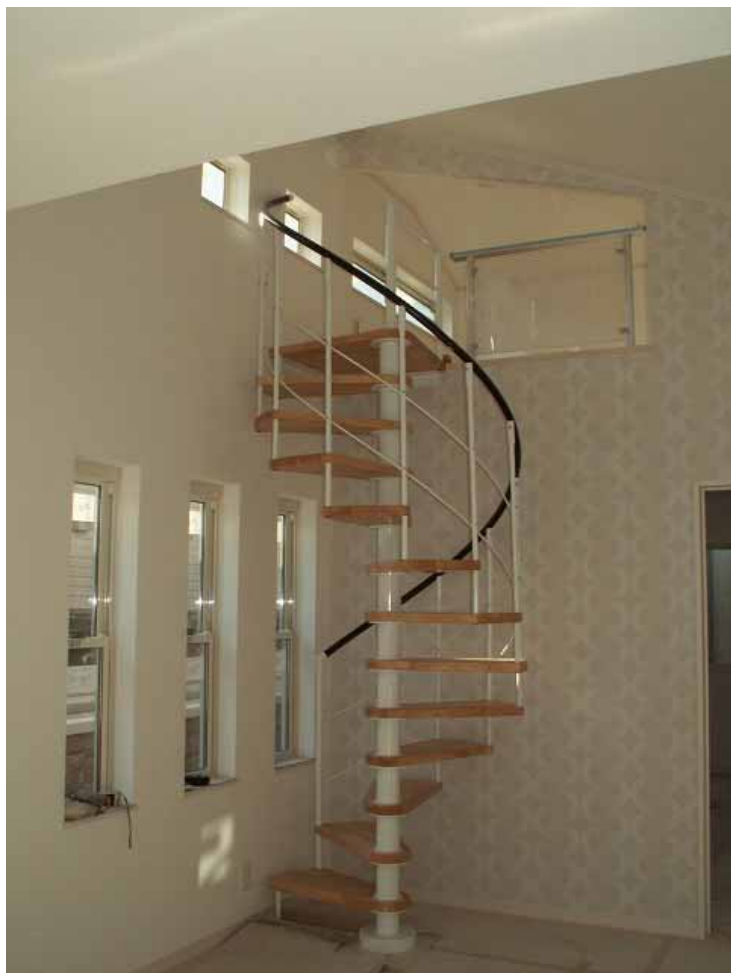
1200 用 リング金物のフランジ部を大きくしてブラケット無し。
