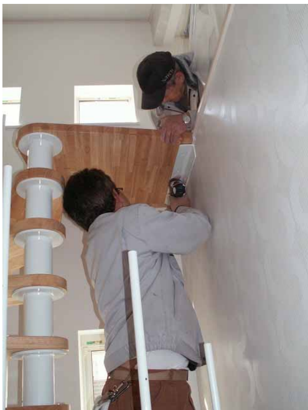
12段組み立て完了。
