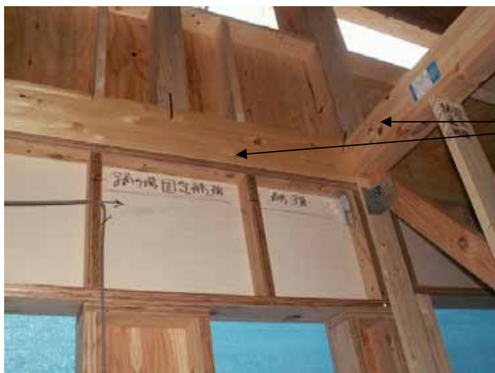
90度2面の梁位置で踊り場をアングル材で固定します。
