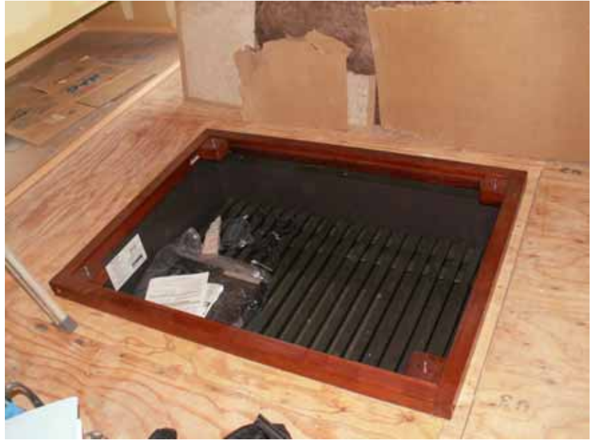
炉縁取り付け状況。
