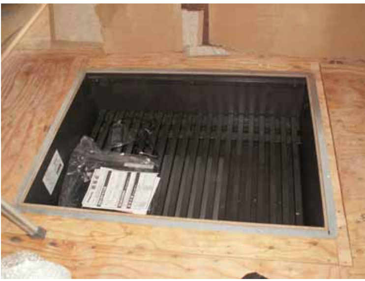
パナソニック電工炉箱取り付け状況。
