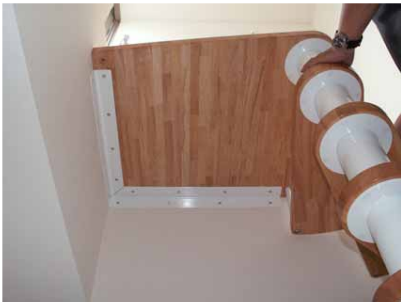
7. 踊り場と壁が 90 度に合った所で アングルにて壁固定します。
