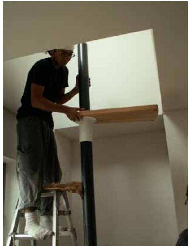
2 . 段板はセンターシャフトの上から 差し込んで組たてます。
