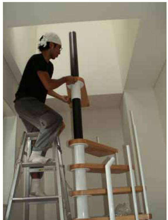
4 . さらに段板を重ね上げながら手摺の縦 柱も取り付けて行きます。
