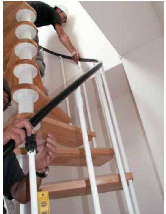
8. 手摺を固定します。この手摺の黒はお施主様のこだわりの色でした。
