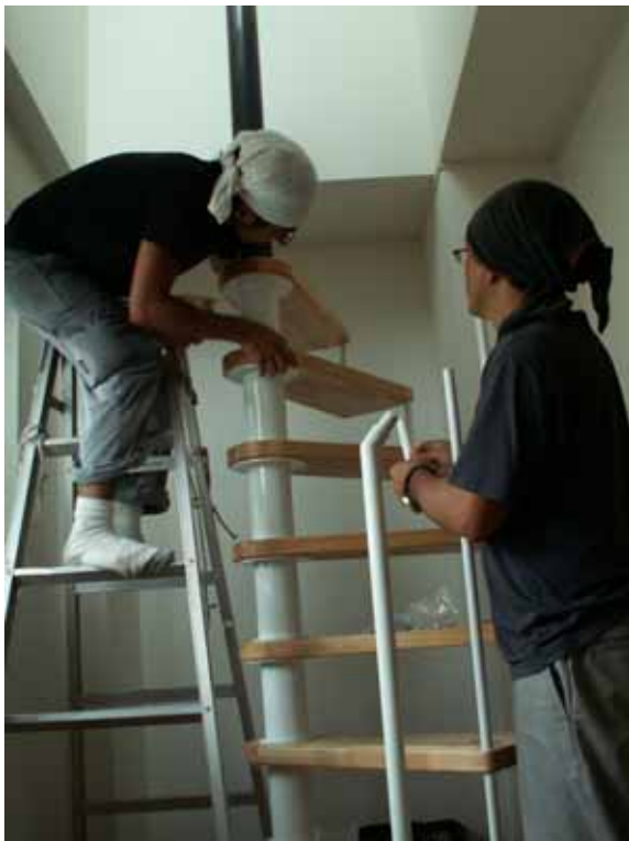
5. 踊り場近くまで段板を重ね上げていきます。
