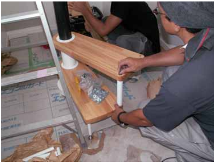
1 . センターシャフトを床固定し、 1,2 段と組み立て開始。
