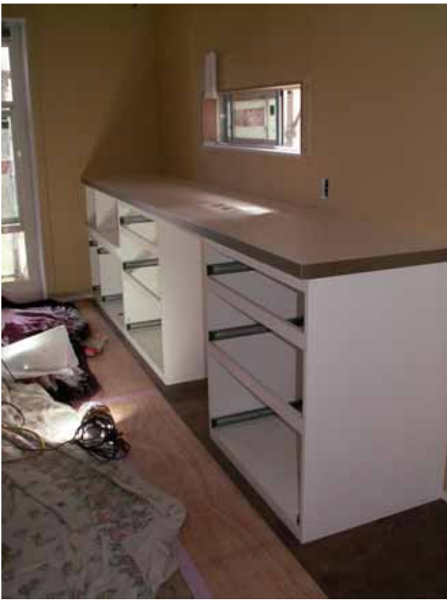
箱組みたて状況です。
