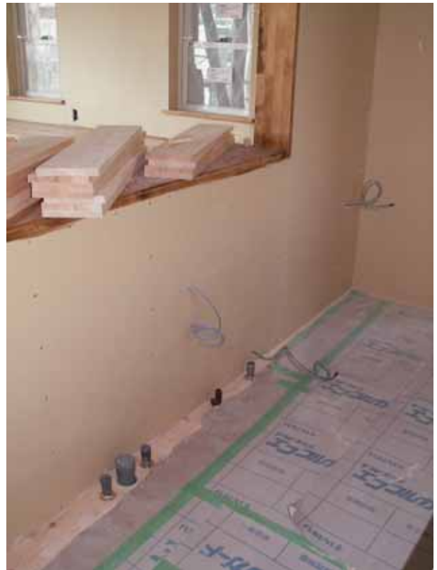
配管、配線状況です。
