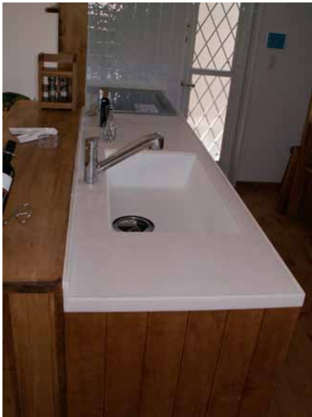
天板人工大理石部仕上がり全景です。 キッチンの笠木ともうまく収まりました。
