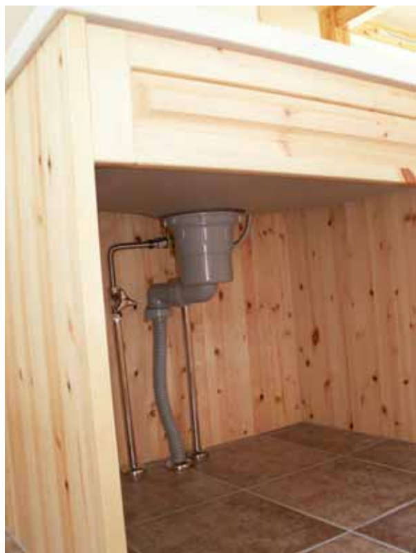
排水は短尺タイプとし、シンク下にスペースを確保しています。
