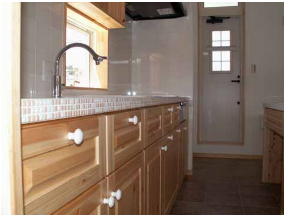
人大天板の小口タイル貼り状況です。
