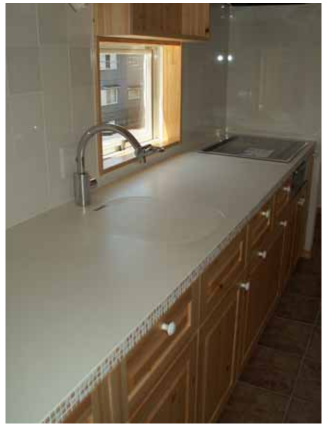
シンク部人大蓋取り付け状況。 指掛り加工。
