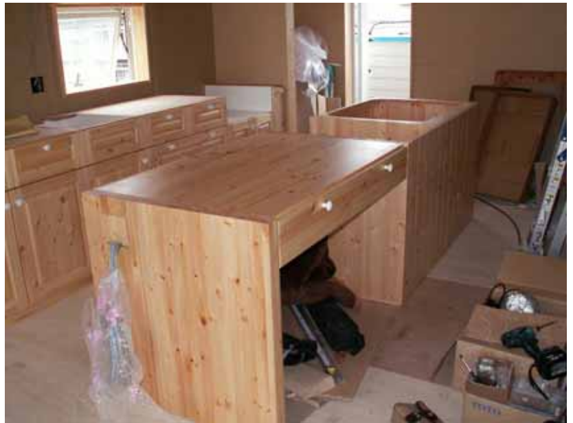
リビング側組み立て状況。
