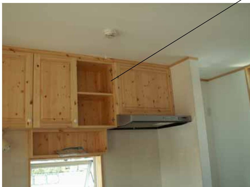
前板左側より2本ボルト固定です。
