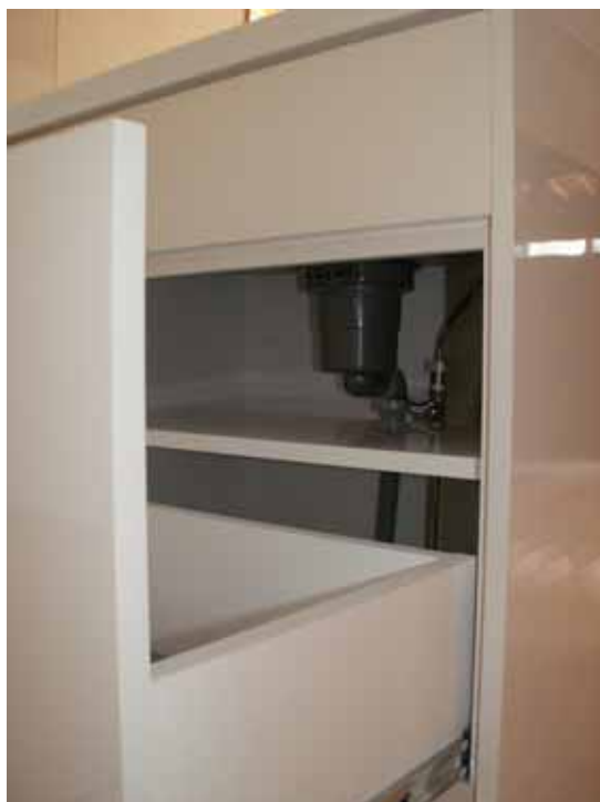
シンク下の大型引き出しと可動棚
