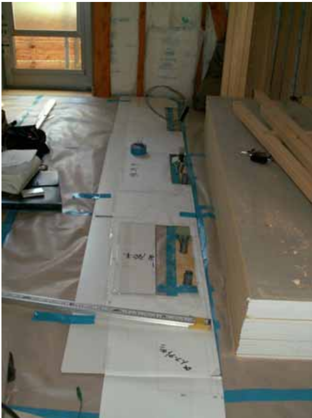
キッチン位置墨だし、配管、配線のチェック。
