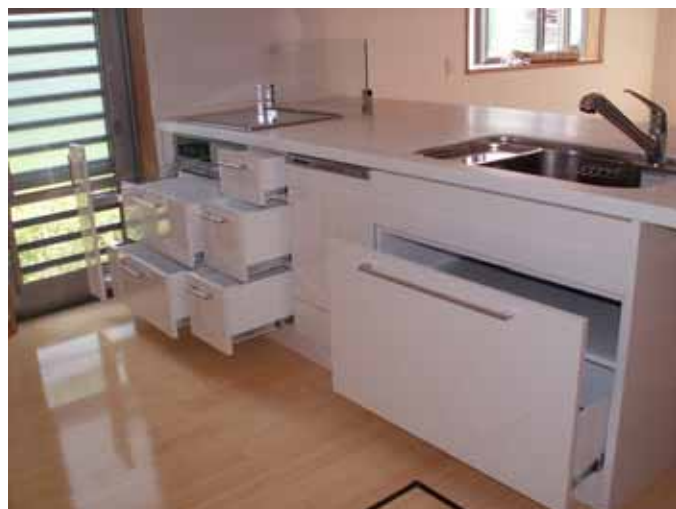
引き出し開放状況
