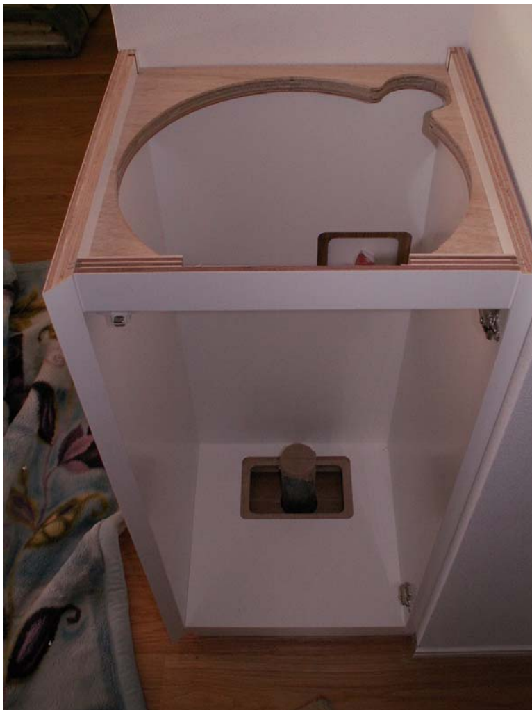
洗面台のボックス固定状況です。
