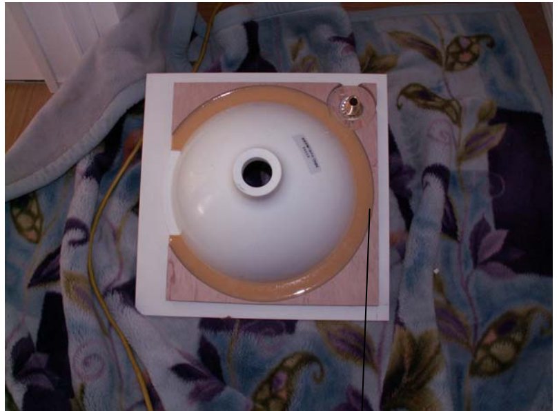
人工大理石天板にボウル固定状況です。
