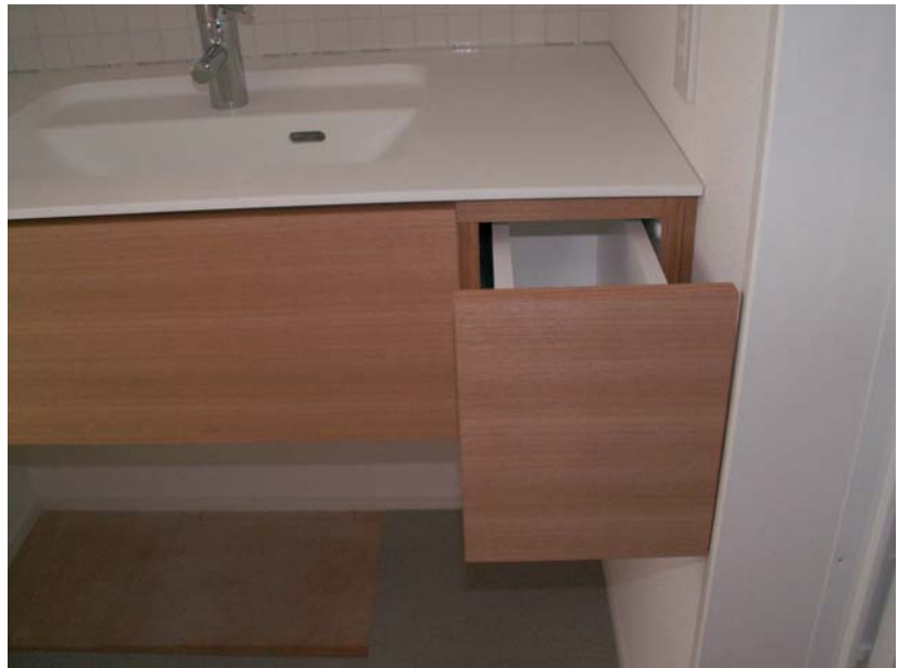
引き出し前板と浴室ドア枠とのクリアランスは5 mm程度です。
