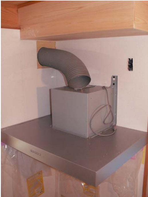
レンジフード取り付け。
