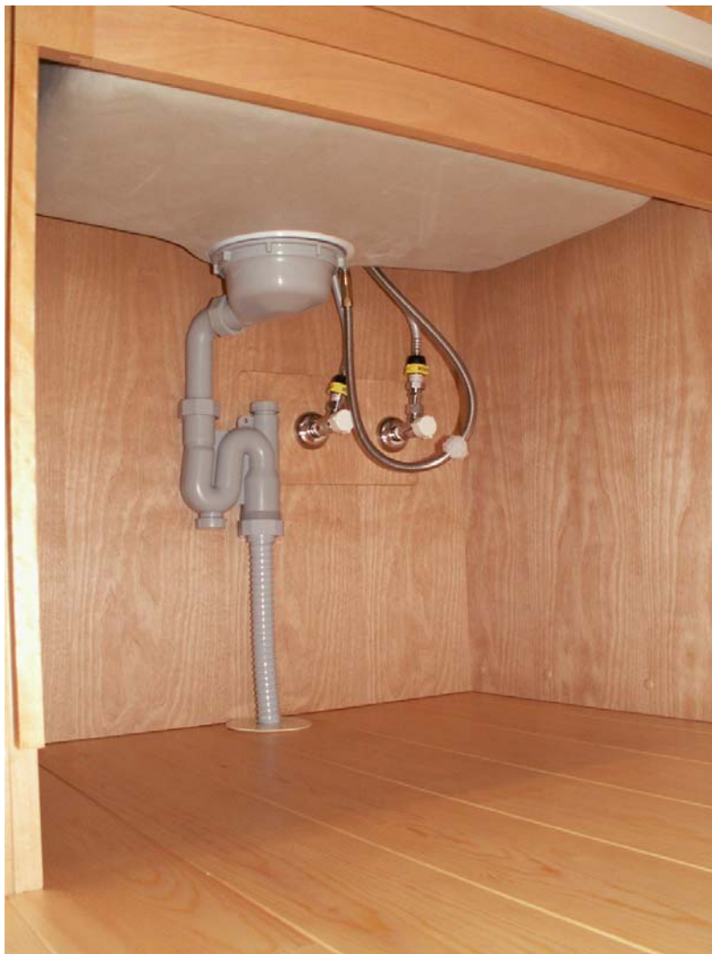
排水トラップ カクダイ薄型トラップ 4526 これで、シンク下に収納スペースを確保できます。
