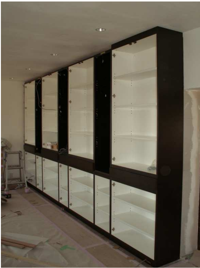
箱のみ取付け完了。天井より固定する。
