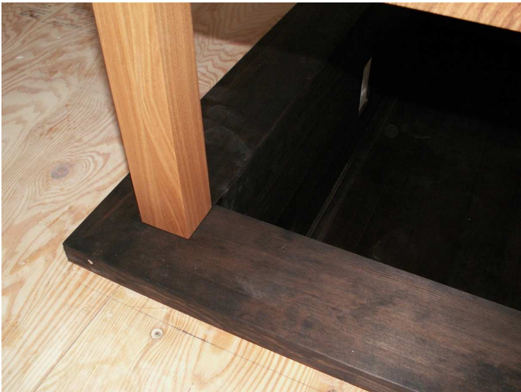
炉縁と座卓角足との収まり状況です。
