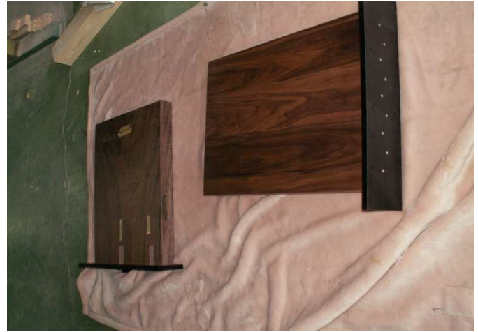
板脚固定プレート取付け。
