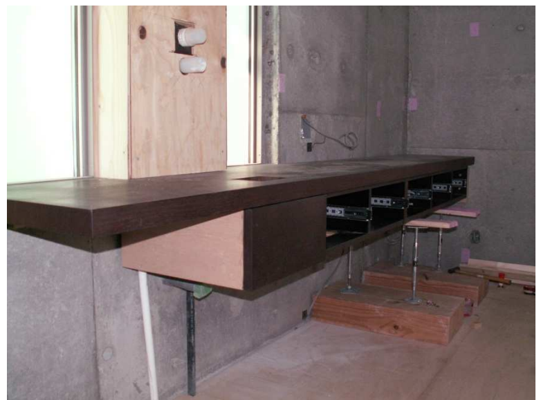
ブラケットを取付け、引き出しボックスをセットし、 天板を窓台部に差し込んで固定。 このあとフカシ壁を作ります。
