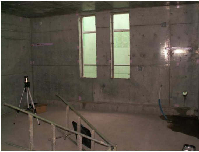
取付け前状況。
