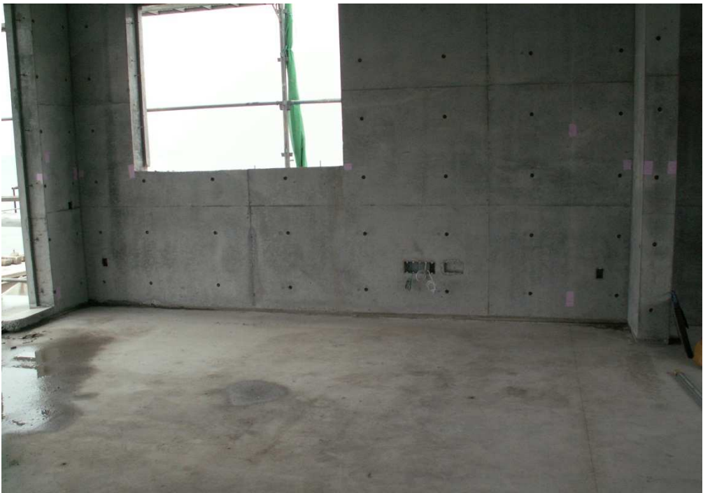
TV ボードの取付け位置。壁のコンセント位置を測定し家具背板に先行穴開け。
