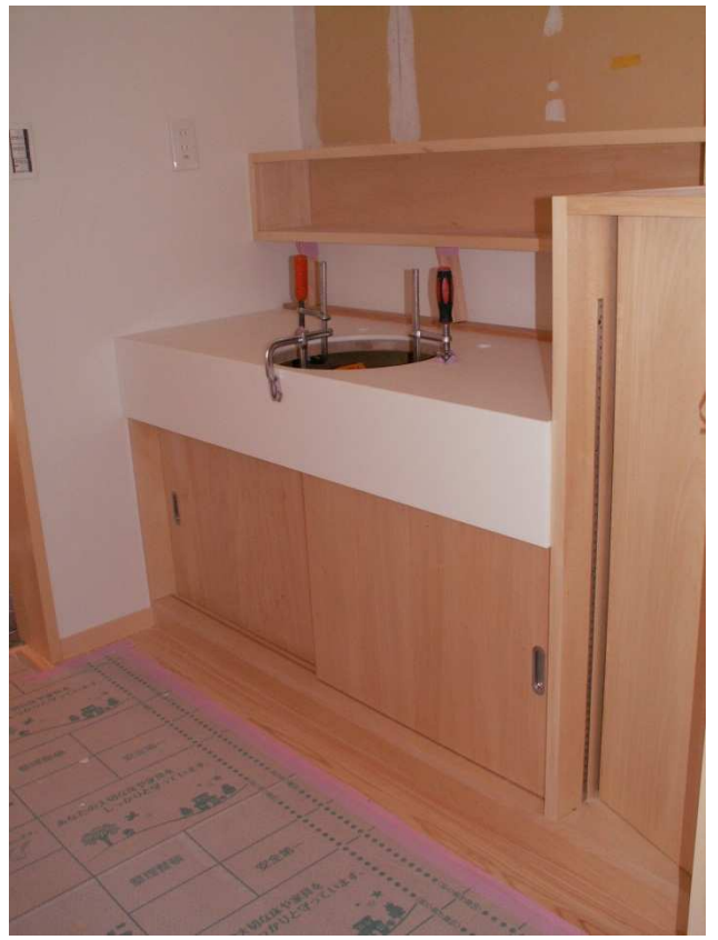
人大天板貼り付け完了。
