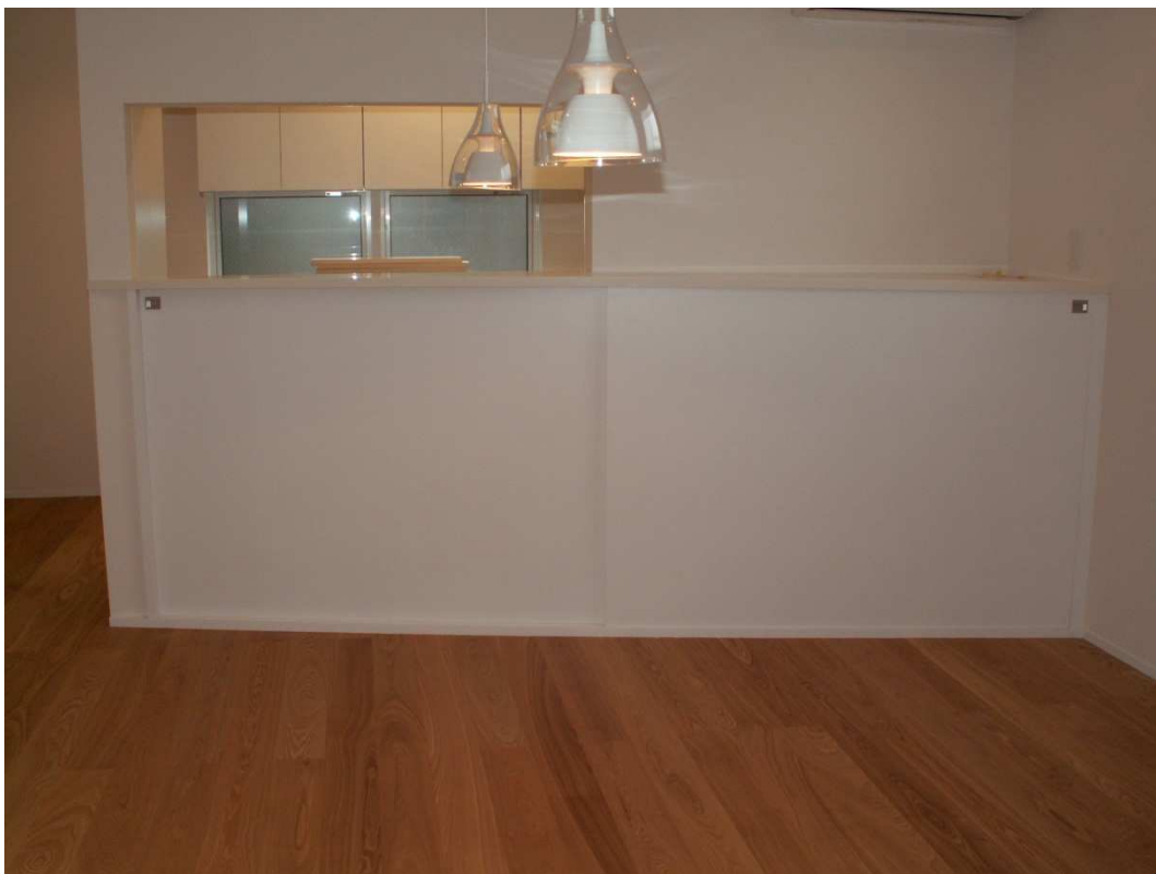
W1530*H1090 の 2 枚引き戸を取り付けて完了です。
