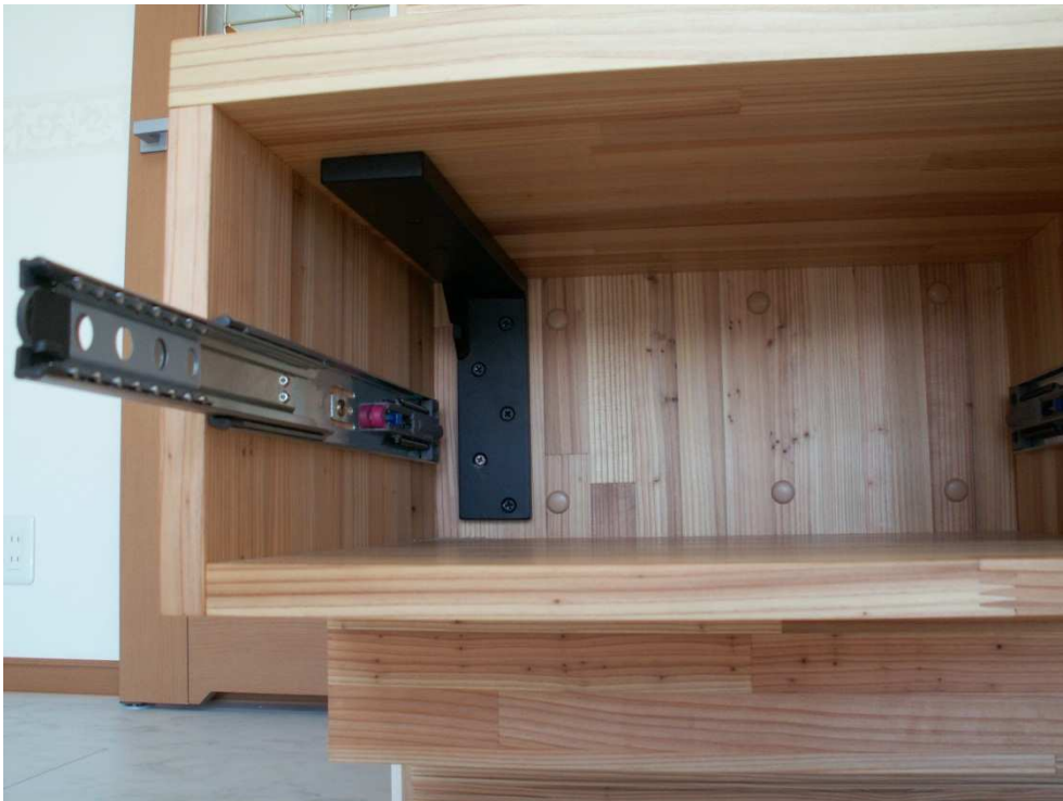
壁固定ブラケット取付け 状況です。
