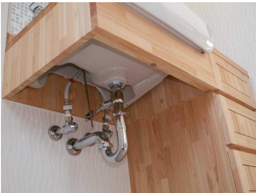
ボウル部の配管部納まり状況。
