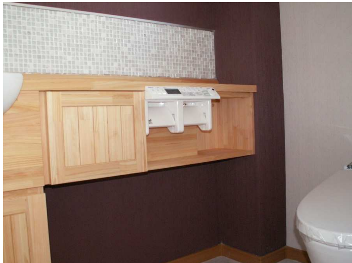
リモコン付き2連巻紙器取付け状況。
