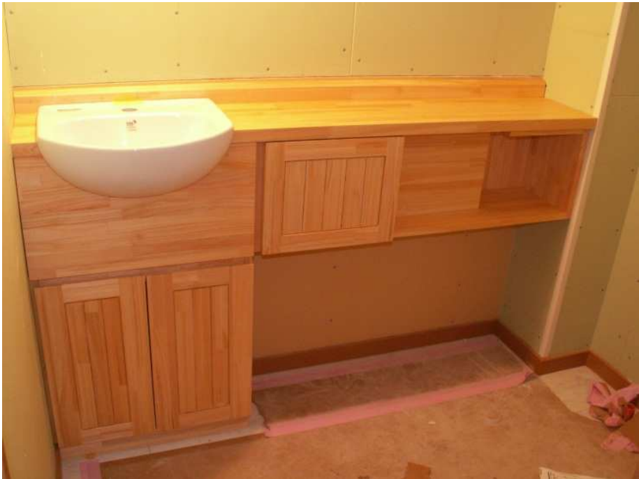
組立完了時状況。
