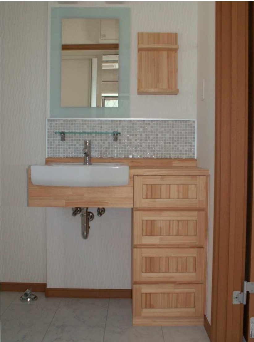
仕上がり全景です。 塗装はガラス塗料グラノール艶消し 天板は4回塗り。
