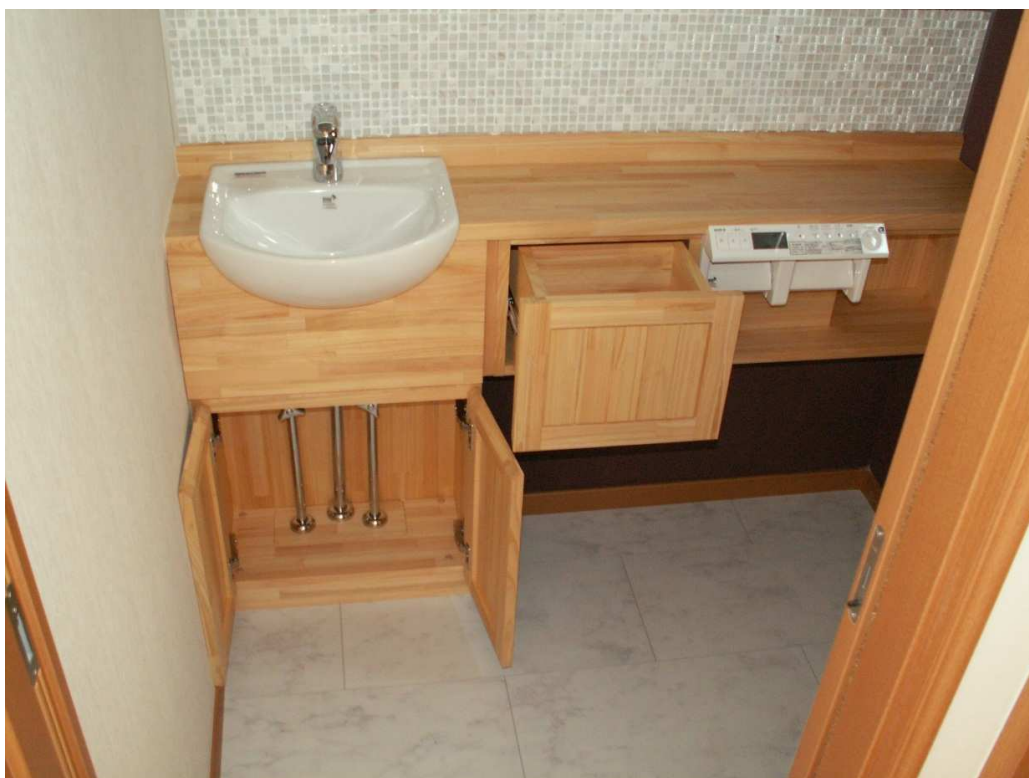
収納扉、引出し オープン状況。
