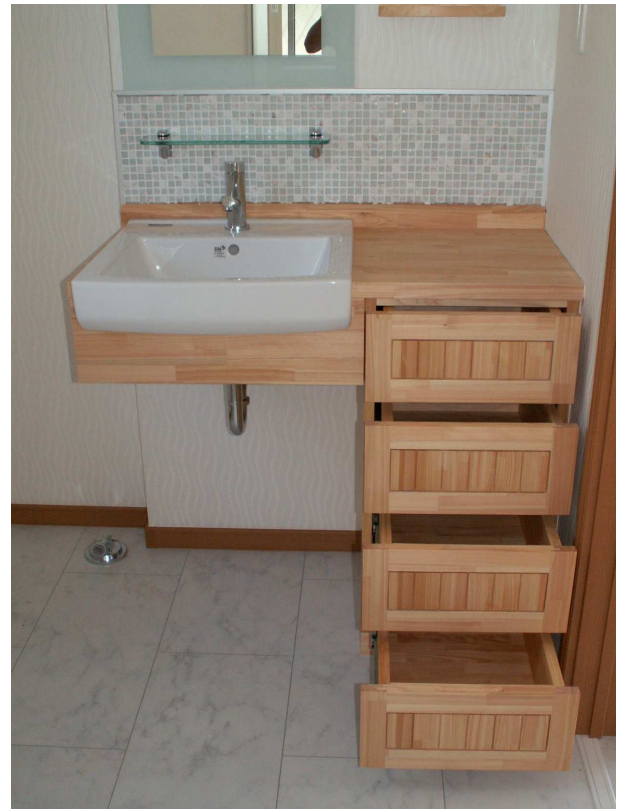
ドア枠とのクリアランスの確保。 引出しはLamp ソフトクロージング 4070 レールを使用しました。
