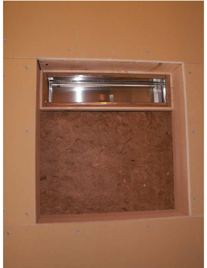
内壁プラスター貼り時状況。
