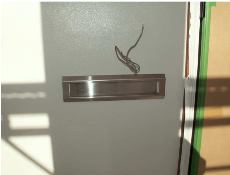
外壁側ポストロ 取付け状況。 (杉田 ACE ポストロ Cタイプ)
