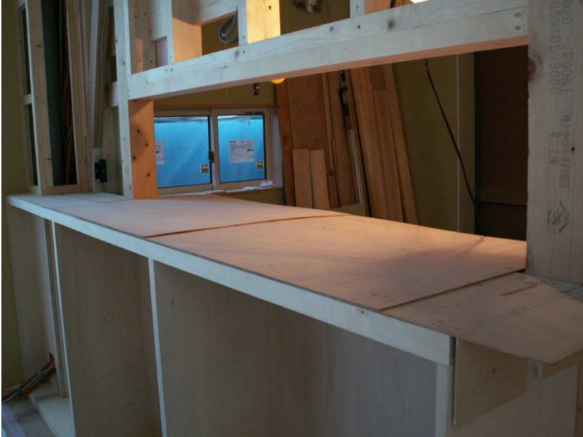
笠木天板の薄ベニヤでの型取り状況。
