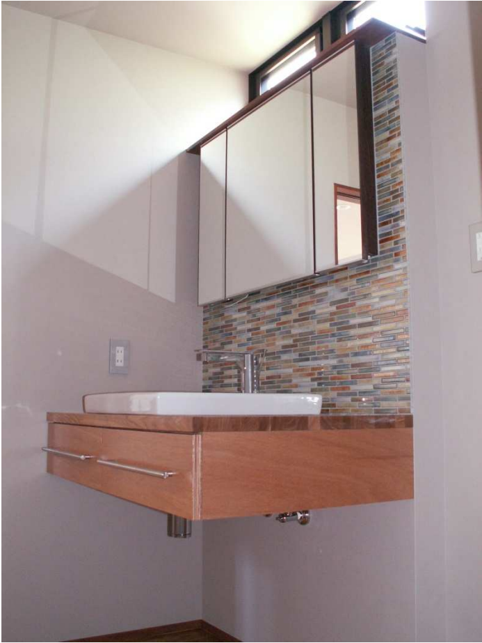
壁固定納まり状況。
