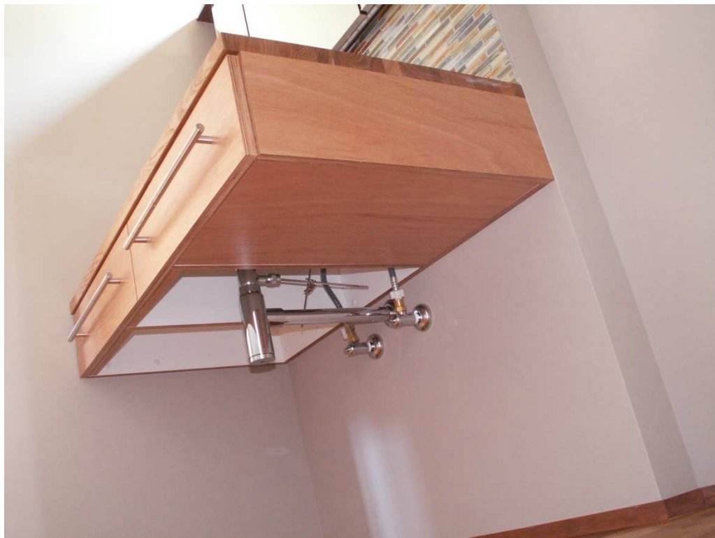
下面状況。 下面、小口もラワン仕上げです。
