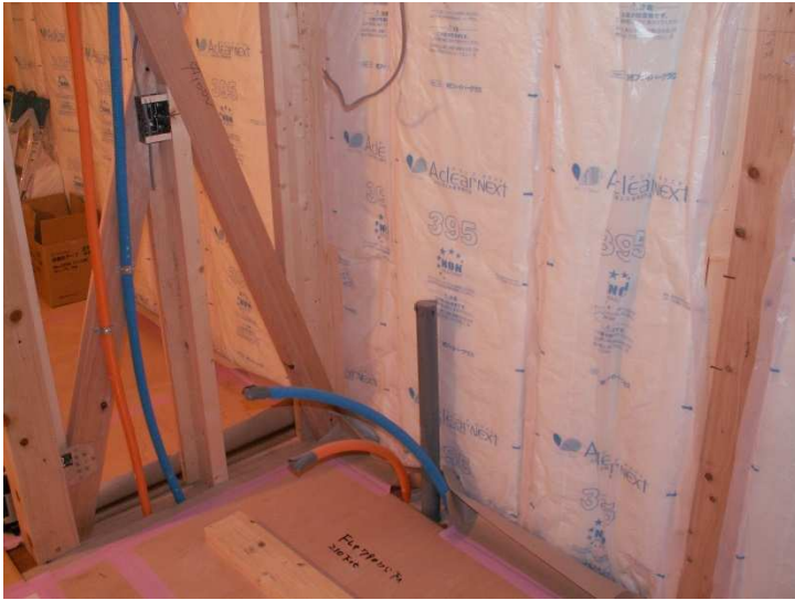
背面はフカシ壁となり、壁排水です。 フカシ壁に壁固定用の板を埋め込みます。
