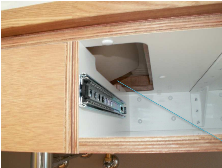
背面はフカシ壁となり、壁排水です。 フカシ壁に壁固定用の板を埋め込みます。
