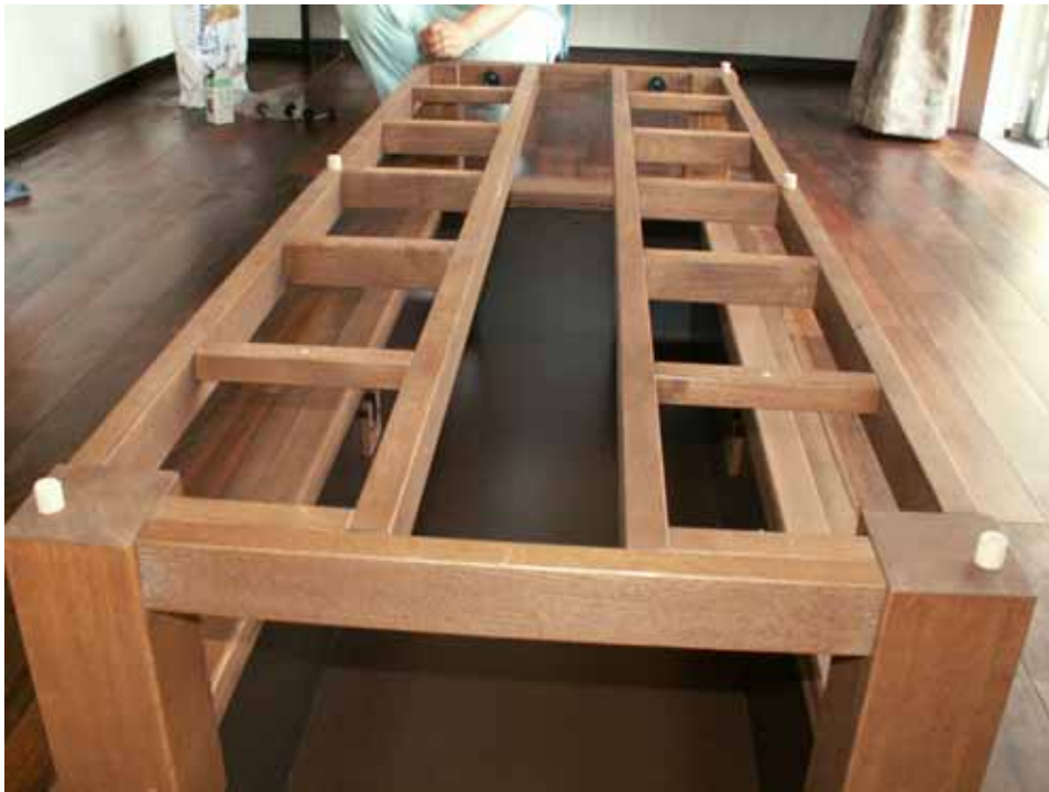
脚に天板固定用ガイドピンを取り付けます。
