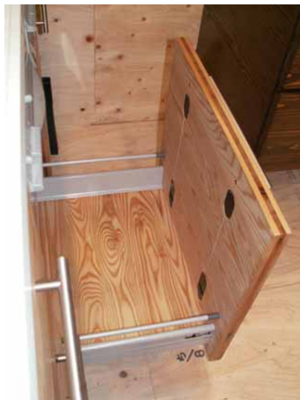
ガスコンロ下収納前板 反り防止 2 箇所
