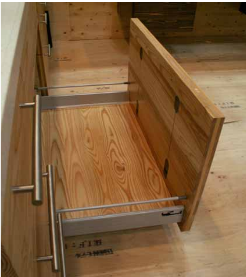
シンク下引出し前板 反り防止 2 箇所
