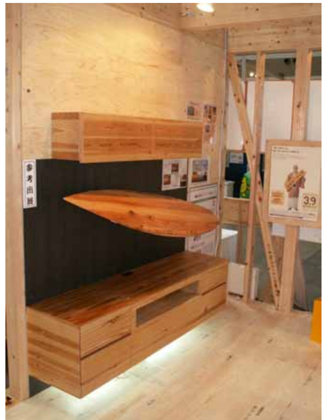
床浮きブラケット固定 下部照明付き
