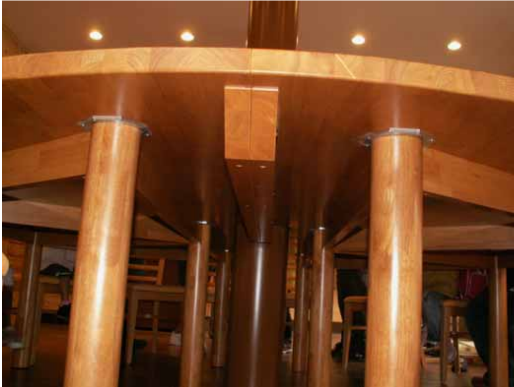
テーブル接合部です。
