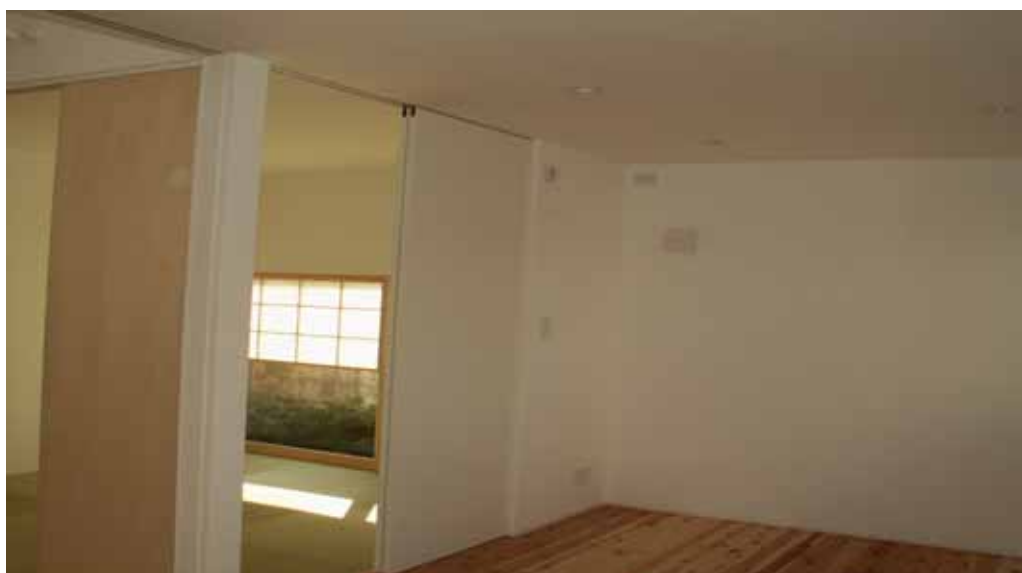
間仕切収納設置前
