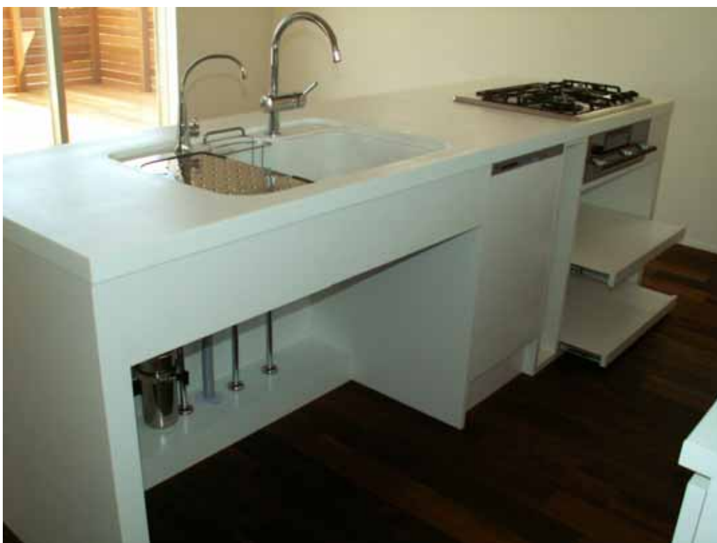
配管露出。 オープン棚 （フルスライド） 中央部：食洗機
