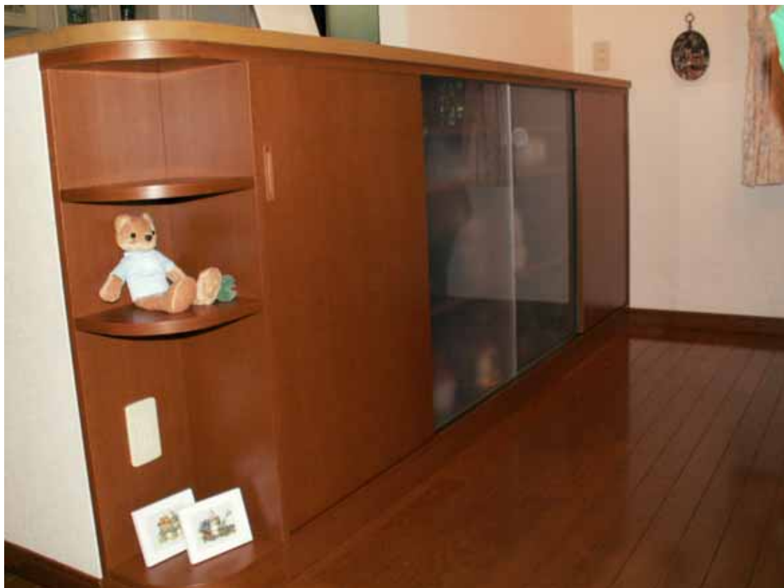
天板部の隙間小口貼りを行い、工事完了です。
