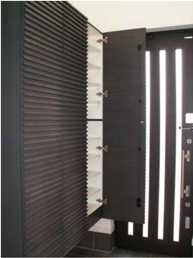
扉裏の反り防止金具取り付け状況。
