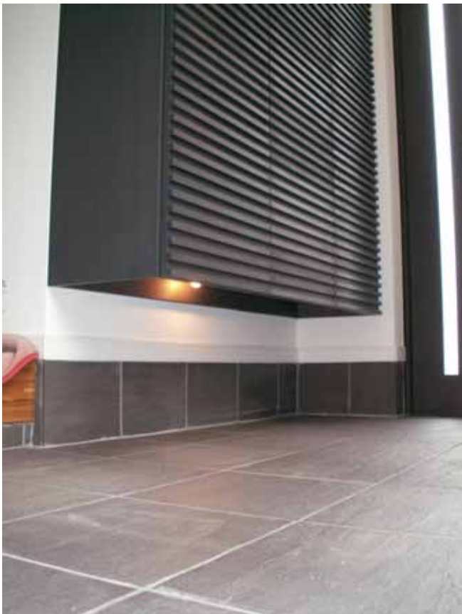
下部照明ボックス状況。
