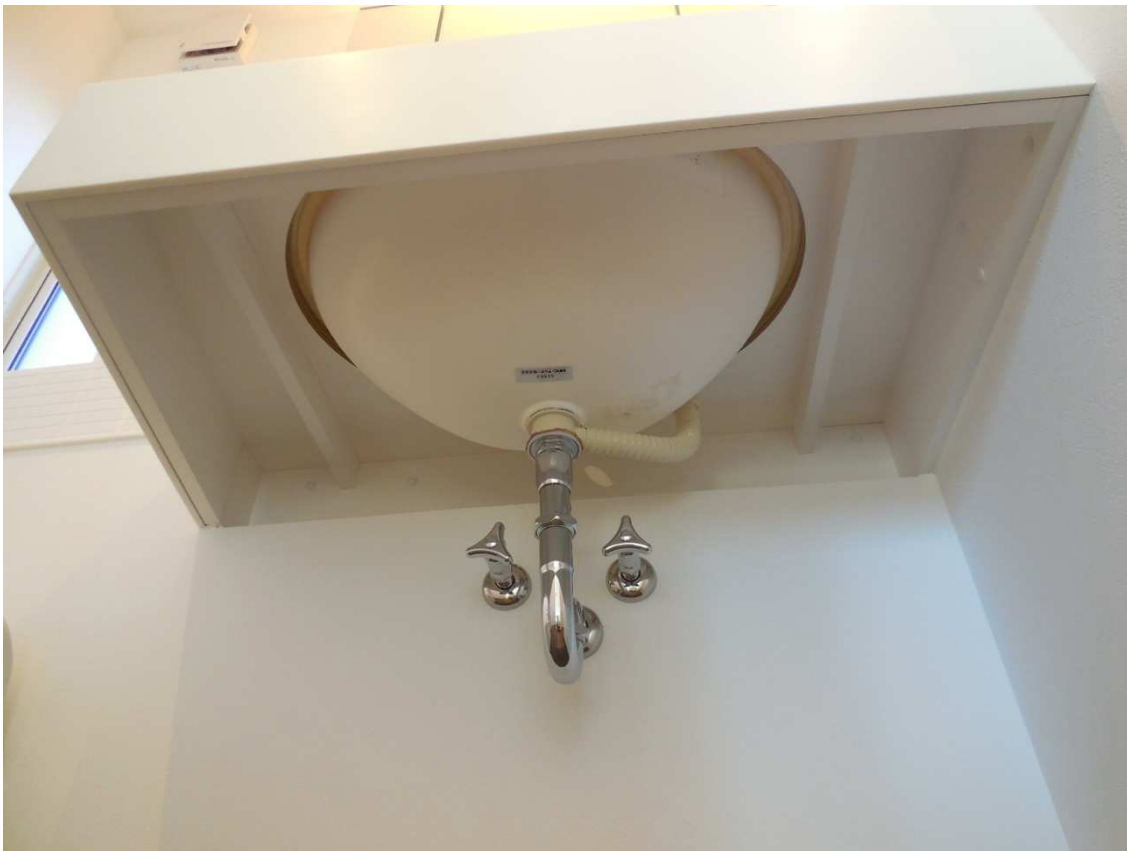
箱天板の下面の納まり状況です。
