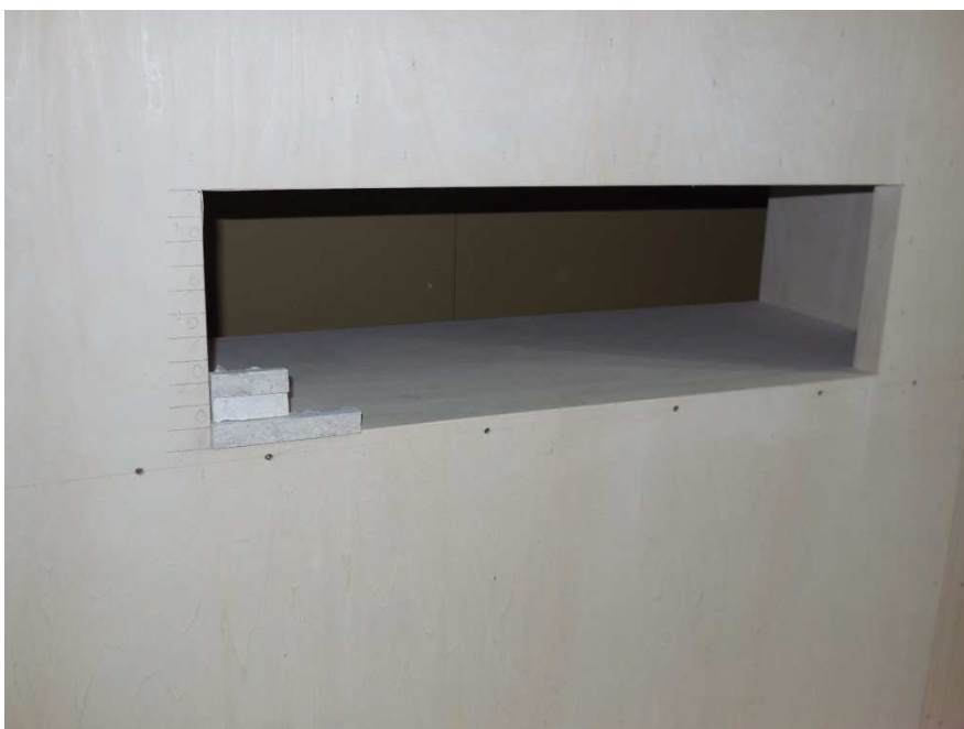
横格子枠切り欠き部のタイル割付の採寸。
