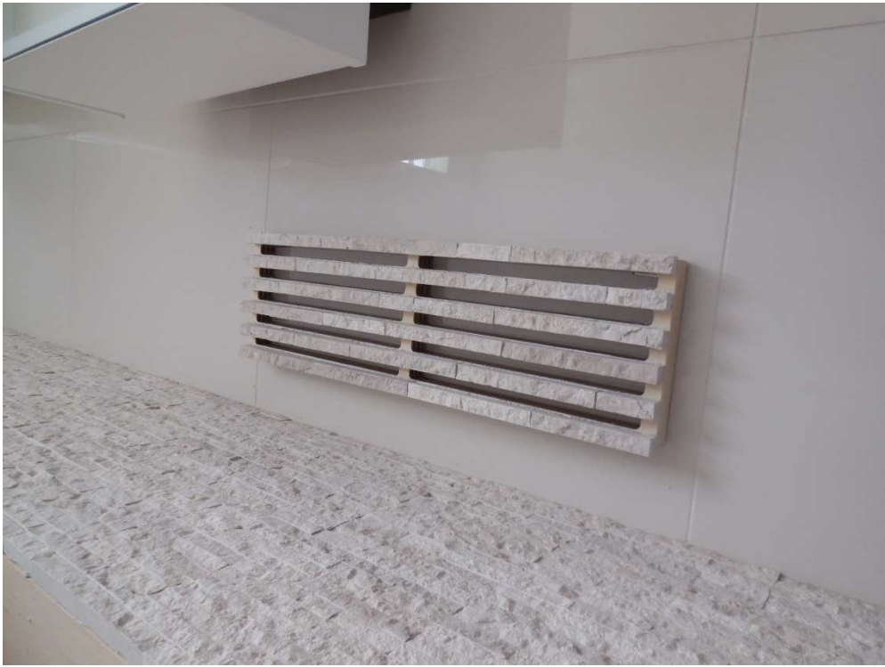
NC 加工板へのタイル貼り付け状況。
