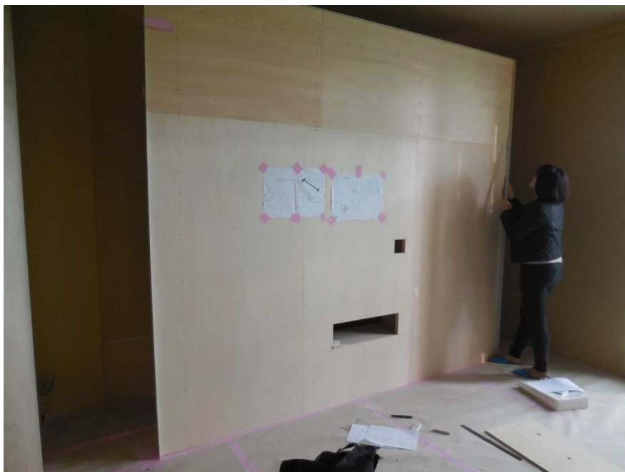
壁掛け TV 用タイル壁下地状況。
