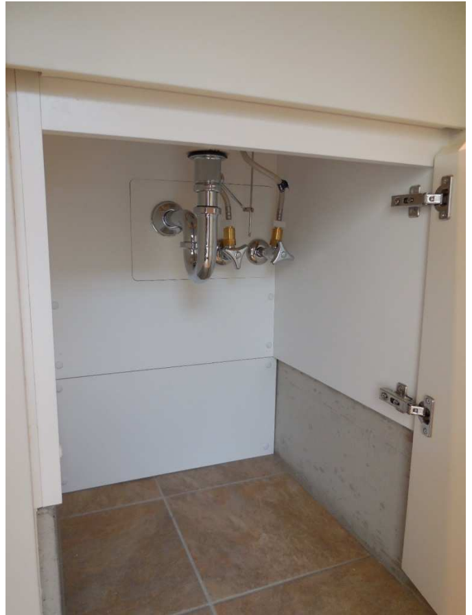
配管取り付け状況。 扉を下に長くして基礎コンクリートを隠す。
