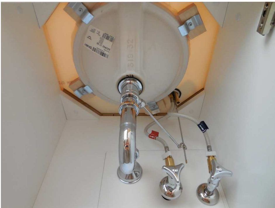
ボウル、配管取り付け状況。
